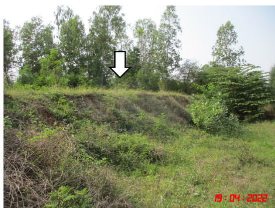
รูปที่ 2-13 คันทำนบดินรอบพื้นที่ทำเหมือง
