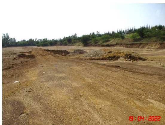
รูปที่ 2-3 การถมกลับพื้นที่ที่ผ่านการทำเหมือง
