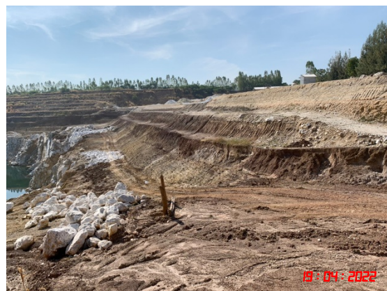
รูปที่ 2-3 การถมกลับพื้นที่ที่ผ่านการทำเหมือง
